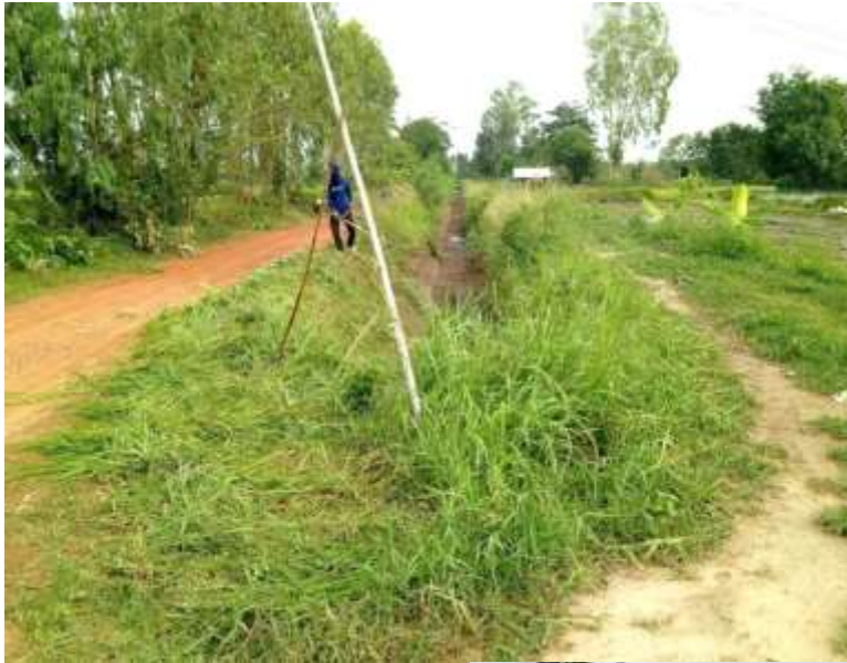
รูปที่ ข7 งานซ่อมแซมคลองส่งน้ำสาย 1L1-RMC(EXT) 0+000 - 1+000 ในปีงบประมาณ 2560
