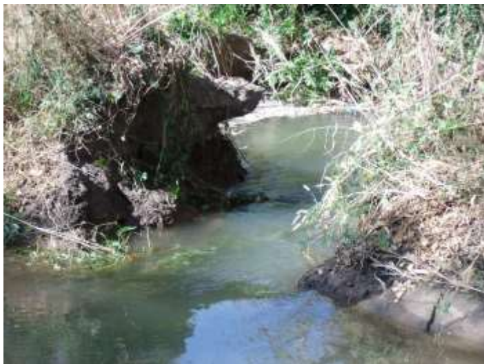
รูปที่ ค29 ซ่อมแซมคันคลองขาด กรณีเร่งด่วน คลอง 1R-2L-RMC กม.12+480
