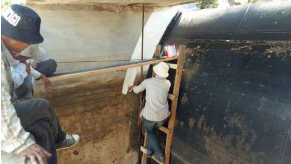
รูปที่ ค28 ซ่อมแซมบำรุงรักษาอาคาร CH 28+000 คลอง RMC ให้พร้อมใช้งาน
