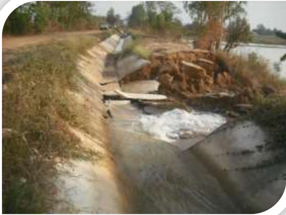
คลองส่งน้ำขาดระหว่างส่งน้ำ
