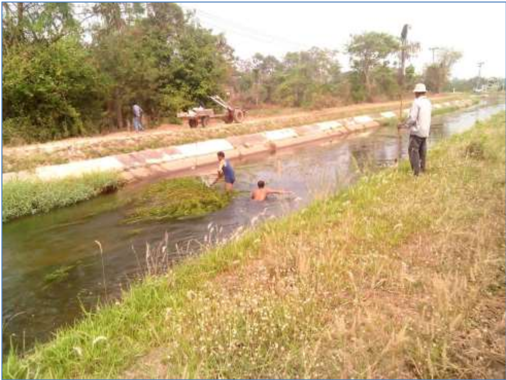
รูปที่ 27 การกำจัดสาหร่ายในคลองส่งน้ำ 2L-RMC ได้ประโยชน์ทั้งการส่งน้ำและการอนุรักษ์คุณภาพน้ำ
