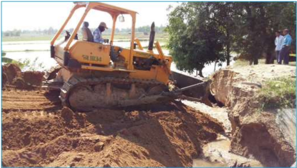
รูปที่ ค25 การซ่อมแซมคลองส่งน้ำสาย 6L-2L-RMC ขาด เมื่อวันที่ 9 สิงหาคม 2559
