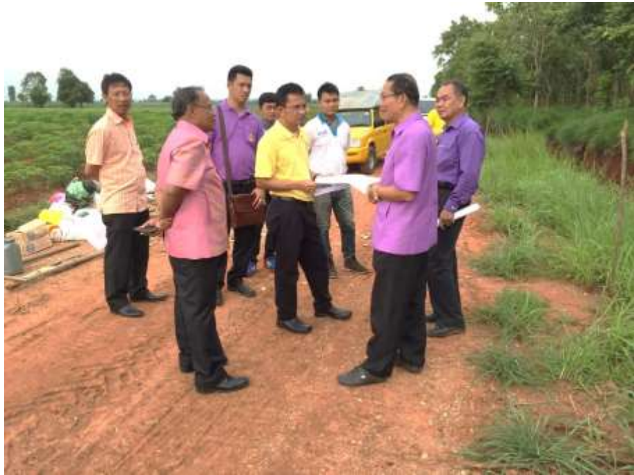
รูปที่ ค20 เทศบาลตำบลบัวบาน ทำฝายกั้นปลา เพื่อผันน้ำเข้าป่าดงระแนง
